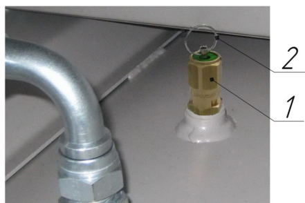
Рисунок 9 – Клапан предохранительный пружинного типа
