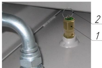
Рисунок 10 – Клапан предохранительный пружинного типа
