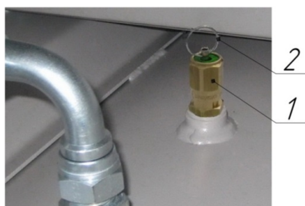
Рисунок 9 – Клапан предохранительный пружинного типа
